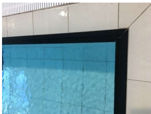
Les rebords des fosses peuvent être protégés par les renforts adaptés : ci-dessous un exemple de renfort en caoutchouc qui recouvre tous les côtés de la fosse d'Antony
